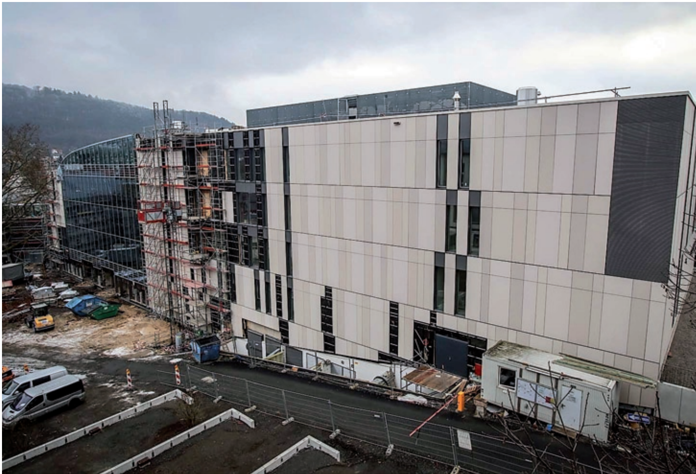
Die Bauarbeiten am neuen Bibliotheksbau der Universität gehen auch im Januar weiter.
